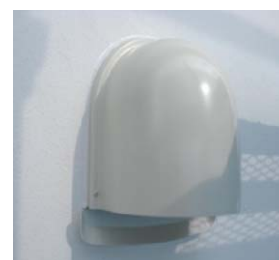
図⑫ 外部フード取付け
