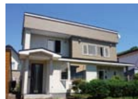
北海道・室蘭市の住宅 (外断熱改修)
