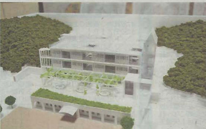
再建後の一関藤の園の外観模型。天井部分に見えるのは電力自給を実現する太陽光発電パネル
