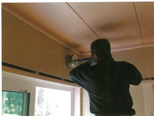
施工中のインヴェンター
