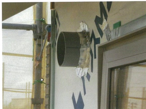
開口とスリーブの間は気密テープで処理
